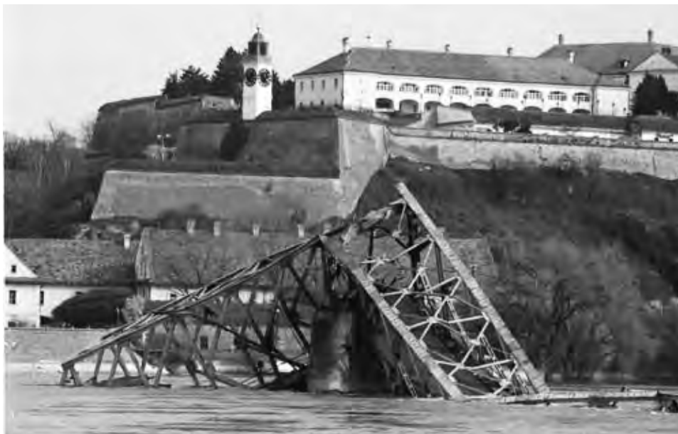
A lebombázott újvidéki Duna-híd
