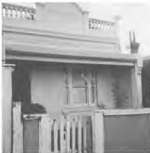
Charwood nevű ház, Farkas Márton utolsó otthona, Melbourne Richmond körzetében (221 Punt Road).
