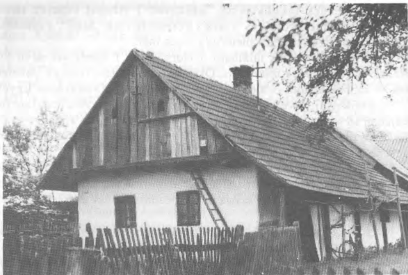
Radamos 97. 1850 körül épített tömésfalú ház. 1916-ban némileg korszerűsítették, akkor kapott cserépfedelel
